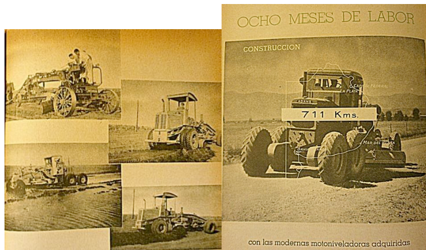
Imagen 14: Operarios viales en trabajo de reparación de caminos. Cuatro años de gobierno, Tomo IV.
