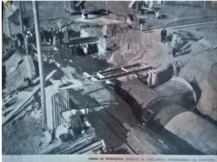
Imagen 13: Obras de hidráulica. Desagüe de Avellaneda. Hormigonado del conducto. Cuatro años de gobierno, Tomo 6, 1938.
